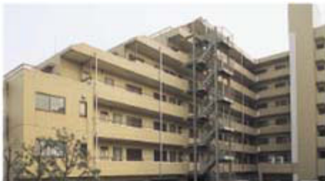
F-6 クレイマンション鶴見 Crane Mansion Tsurumi
