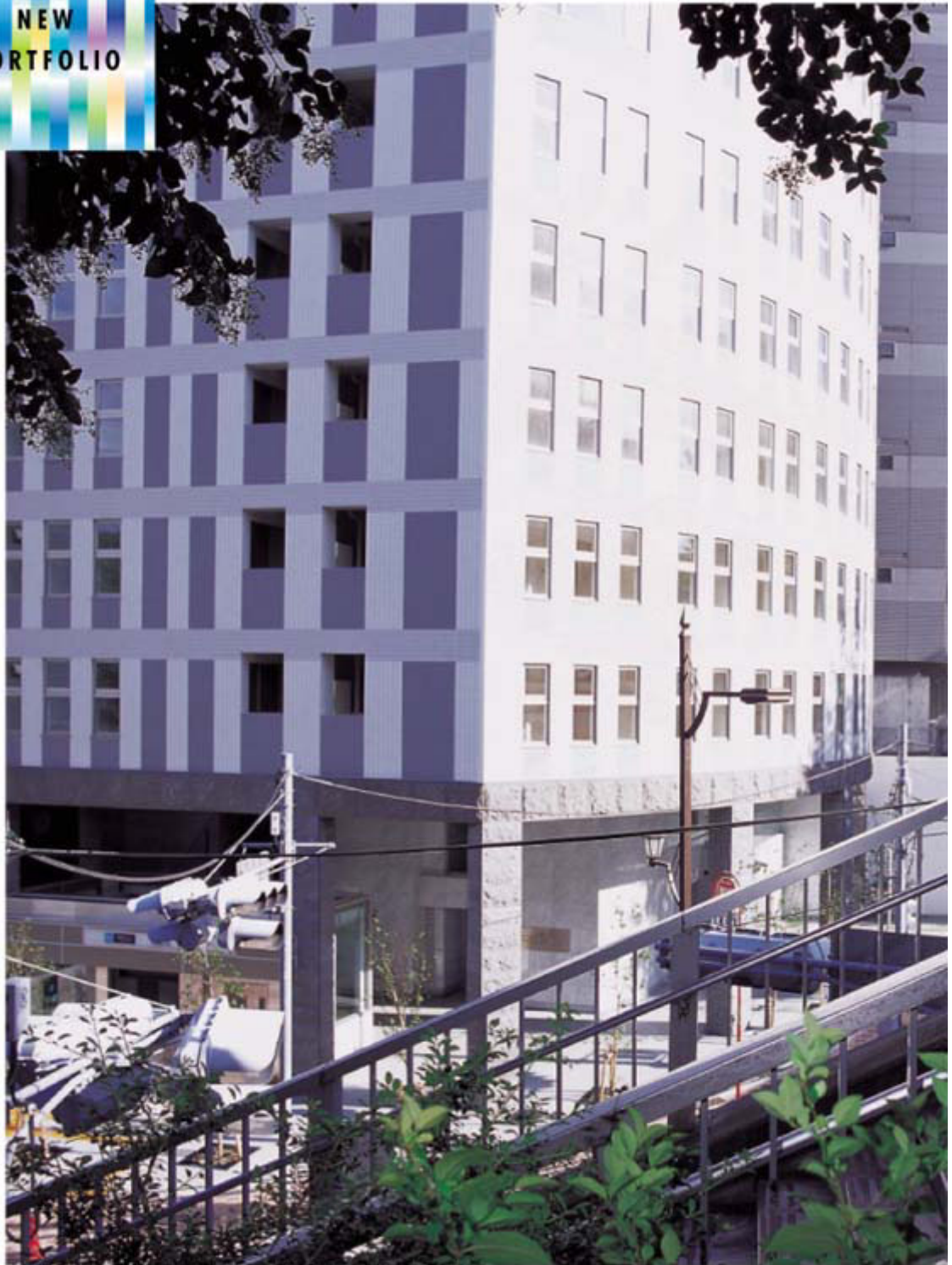
〔注〕上記写真は、パシフィックタワー乃木橋も、当該建物の北側に位置する乃木公園の歩道橋から撮影したものです。
