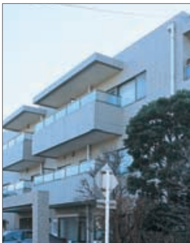
L-4 目黒ヒルサイドコート Meguro Hillside Court
