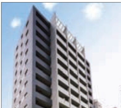
C-12 パシフィックレジデンス水道橋 Pacific Residence Suidobashi
