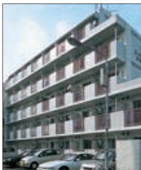
S-13 吉塚AGビル6号館・7号館 Yoshizuka AG Building
