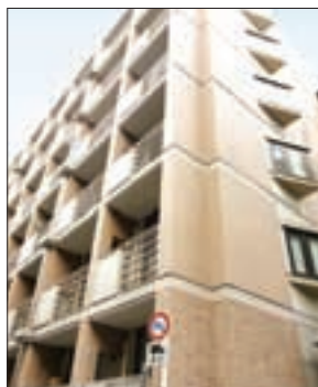
S-25 パシフィックレジデンス笹塚 Pacific Residence Sasaduka
