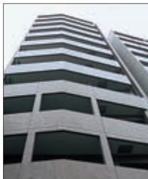
S-8 パシフィックレジデンス新中野 Pacific Residence Shin-Nakano
