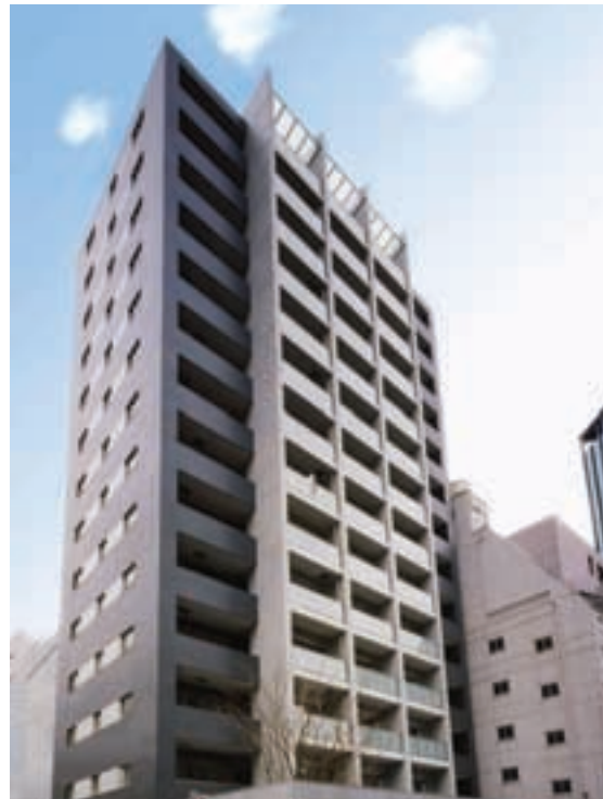
C-12 パシフィックレジデンス水道橋
