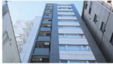
C-2 パシフィックレジデンス千石 Pacific Residence Sengoku
