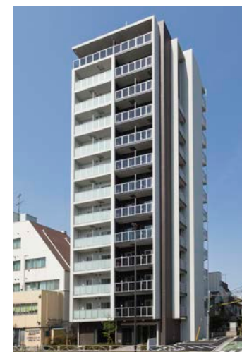
① 品川区東中延 竣工写真
