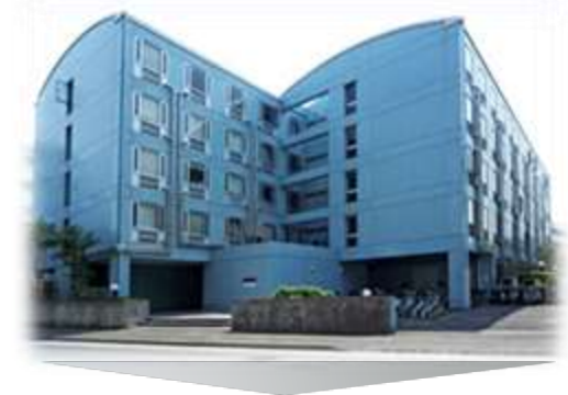
東京・スチューデントハウス和光 (埼玉県和光市)
