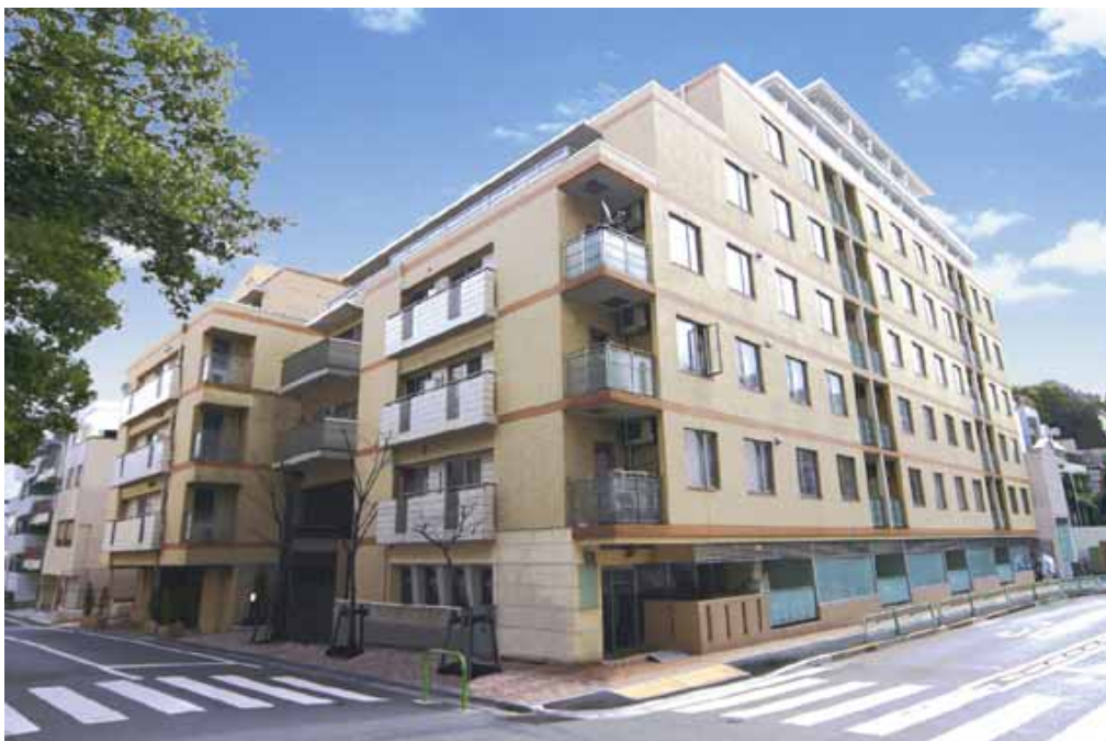
8. パシフィックレジデンス赤坂檜町の外観
